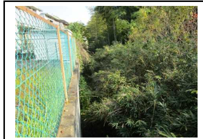
写真2 盛土末端のコンクリート擁壁
