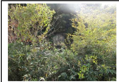
写真3 盛土下流側のため池
