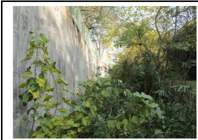
写真1 盛土末端のコンクリート擁壁
