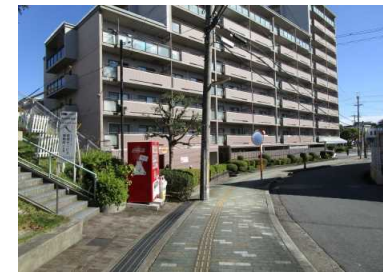
写真3 盛土末端付近の状況
