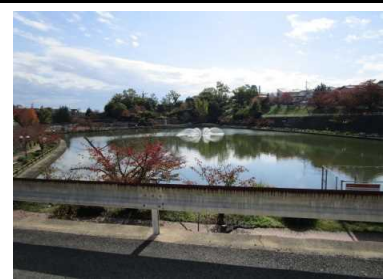
写真37 盛土内のため池
