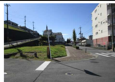
写真5 盛土末端付近の状況
