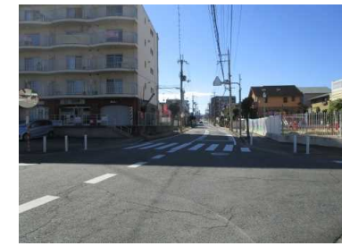
写真4 盛土末端付近の状況
