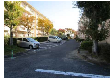
写真1 盛土末端付近の状況
