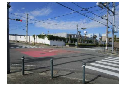
写真20 西側境界付近のは工事中
