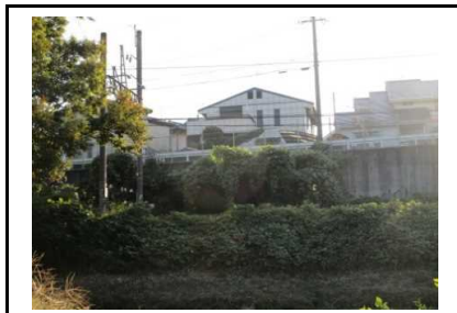
写真2 盛土末端のコンクリート擁壁
