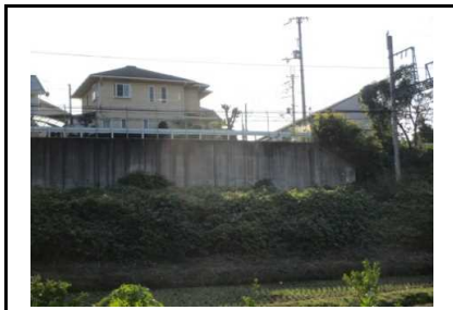
写真1 盛土末端のコンクリート擁壁
