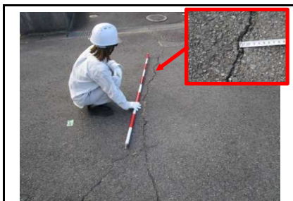
写真5 路面のクラック(1cm)
