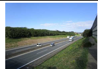
写真21 盛土を縦断する西名阪自動車道
