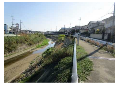
写真1 盛土末端付近の状況
