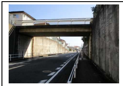
写真10 掘り割り形状の道路状況
