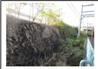
写真1 盛土末端のブロック積擁壁
