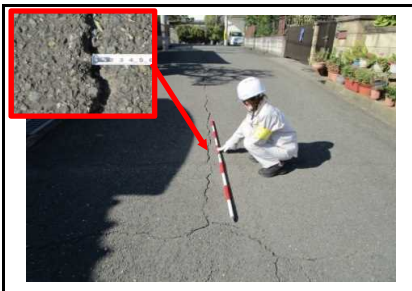
写真9 路面のクラック(1cm)
