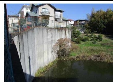
写真3 盛土末端のコンクリート擁壁
