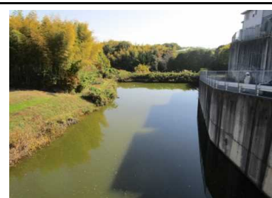
写真7 盛土下流側のため池
