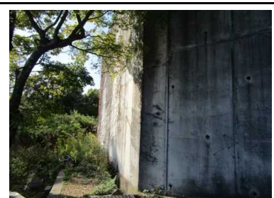
写真5 盛土末端のコンクリート擁壁
