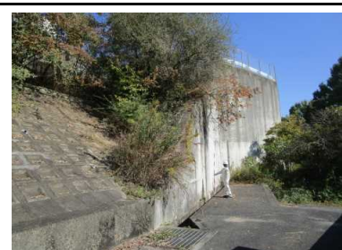
写真6 盛土末端のコンクリート擁壁
