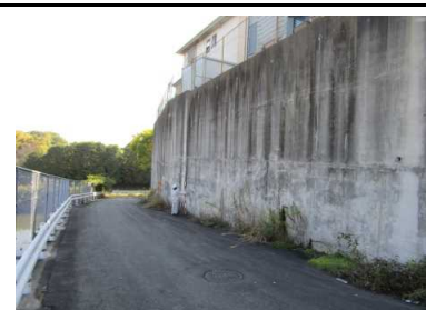
写真8 盛土内の擁壁
