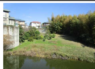
写真2 盛土末端のコンクリート擁壁
