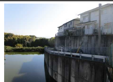
写真4 盛土末端のコンクリート擁壁
