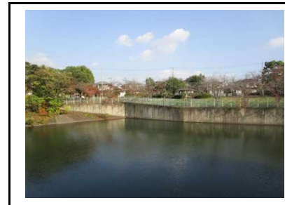
写真24 盛土上流側のため池
