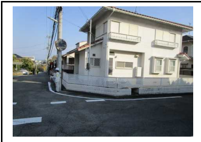
写真13 北側境界付近の土地利用状況
