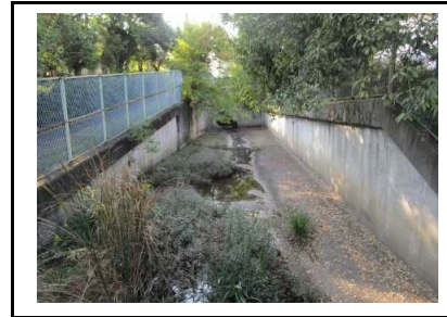
写真4 盛土内を縦断する水路（暗渠）
