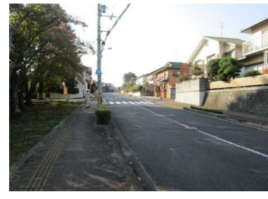
写真2 盛土末端付近の状況
