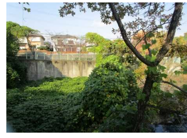
写真3 盛土末端のコンクリート擁壁
