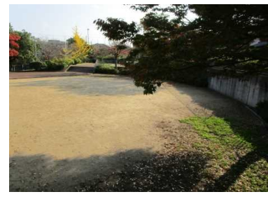
写真5 盛土末端付近の状況
