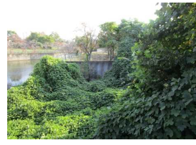
写真4 盛土末端のコンクリート擁壁
