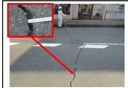
写真18 路面のクラック(2cm)
