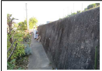
写真1 盛土末端のコンクリート擁壁
