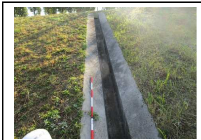
写真5 排水工に異常なし
