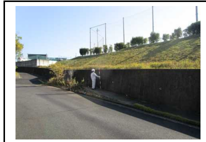
写真2 末端擁壁およびのり面の状況
