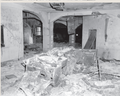
▲福屋百貨店6階内部の被害の様子。火災により内部の物は焼けたが、構造体の損害は軽微だった。広島平和記念資料館（所蔵・提供）
