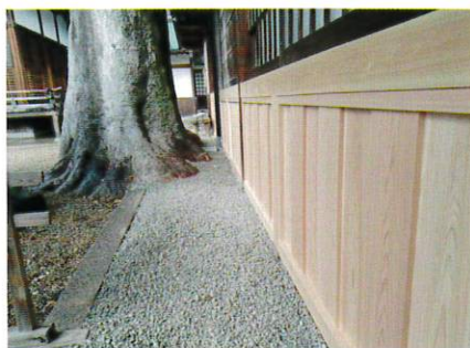
【補修後の腰板】
