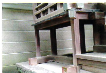
【本殿足元の銅板補強】
