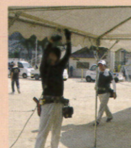
テント設置と 電気工事
