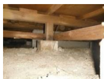
床下にシロアリ被害がないか
