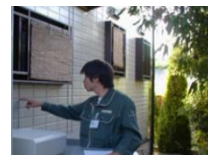
外壁の状態を確認
