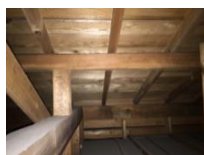
小屋裏に雨漏りの跡がないか
