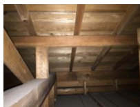
小屋裏に雨漏りの跡がないか
