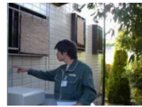
外壁の状態を確認
