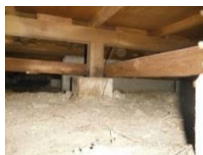
床下にシロアリ被害がないか
