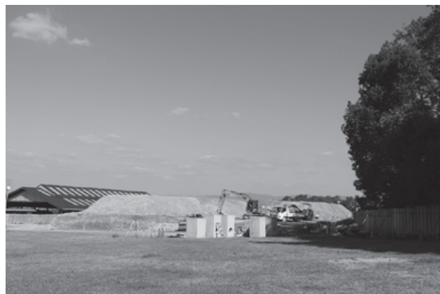
工事着手後(11月撮影)
