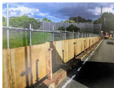
高薮橋補修工事
