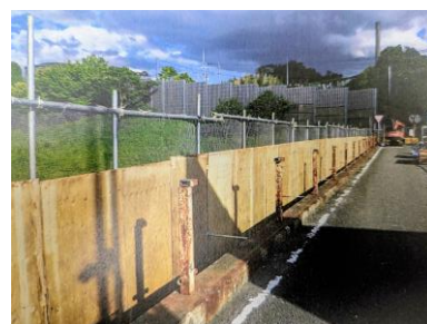
高数橋補修工事
