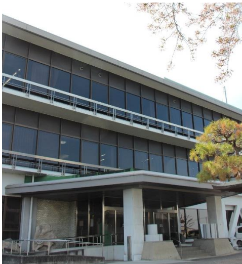
庁舎地下Ⅰ階 自動販売機設置場所
