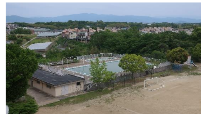
(6) プール、プール棟 (解体後、体育館利用者用駐車場を新設)
