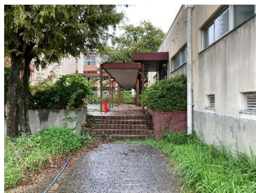
(4) 西側アプローチ (階段解消予定)
