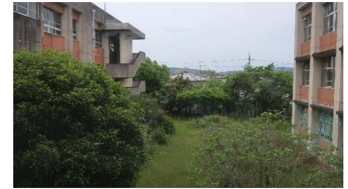
(2) A棟・B棟間スペース (西側)
