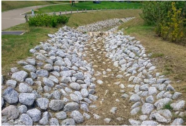
図 47 石張護岸ネット施工例
